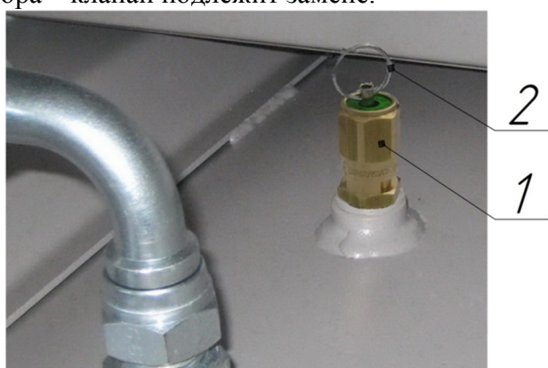
Рисунок 9 – Клапан предохранительный пружинного типа
